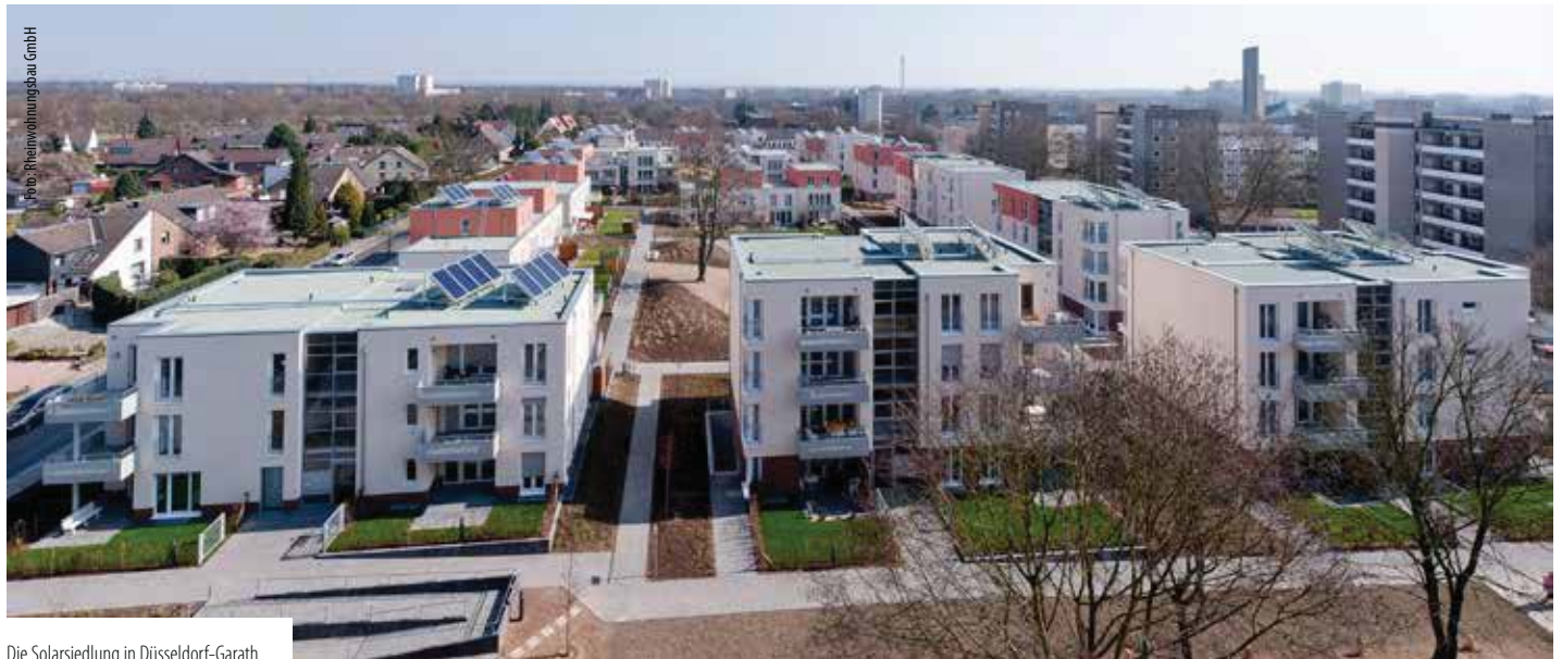
Die Solarsiedlung in Düsseldorf-Garath
